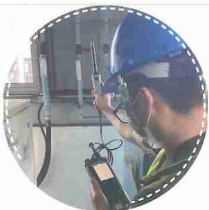
設備機房溫度檢測
